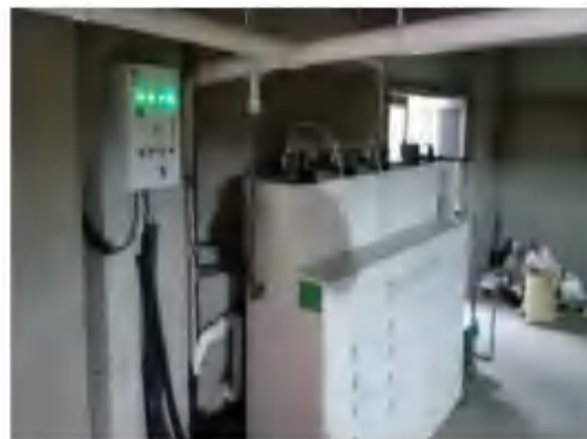
化验室一体化污水处理装置
