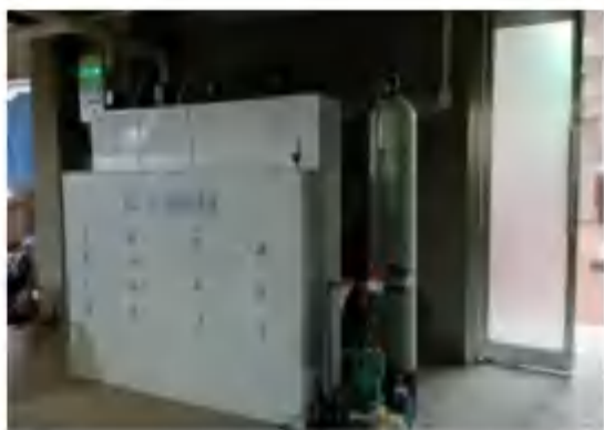
化验室一体化污水处理装置
