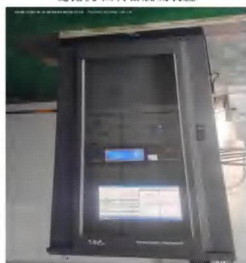
煤气发电烟气在线监测装置
